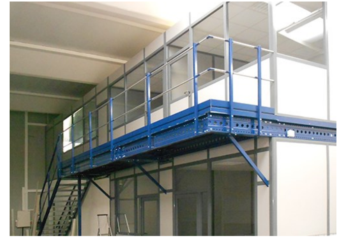
Mezzanine avec porte-à-faux
