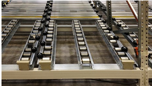
Installation dynamique avec rails séparés en entrée de couloir pour les engins de manutention avec mât non inclinable
