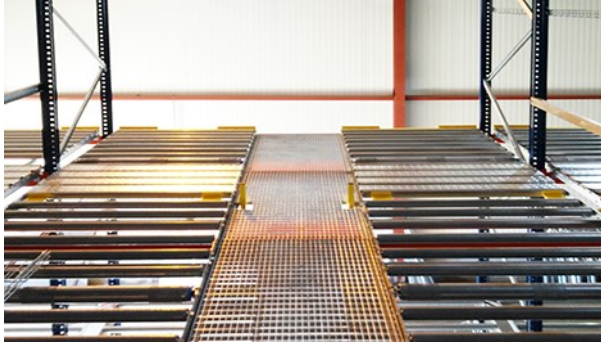
L'aménagement d'allées en caillebotis permet aux employés de circuler entre les couloirs
