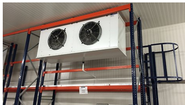
Stockage en chambre froide
