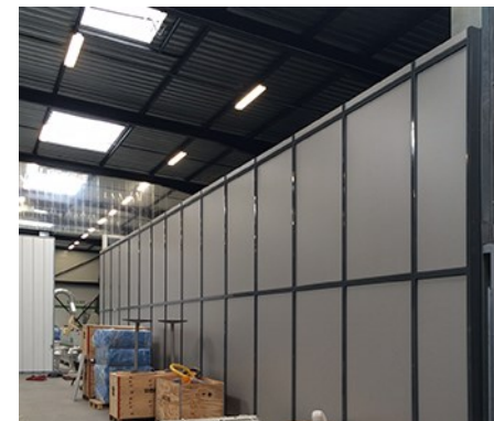
Habillage de la mezzanine sur toute la hauteur avec une cloison d'un seul tenant
