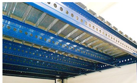
Pose du bac acier sur les solives et les poutres
