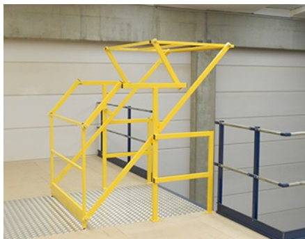
Barrière écluse ouverte pour la dépose de la palette sur la plate-forme
