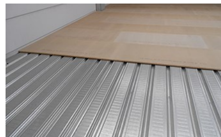
Pose du plancher sur le bac acier galvanisé
