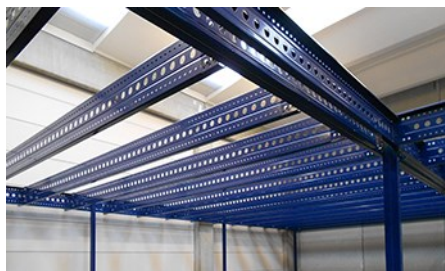
Pose des poteaux, des poutres et des solives
