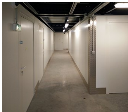
Aménagement de boxes sous la mezzanine
