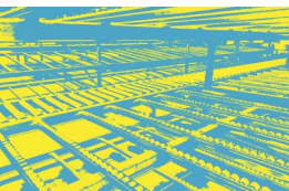
Pose du bac acier sur les solives et les poutres
