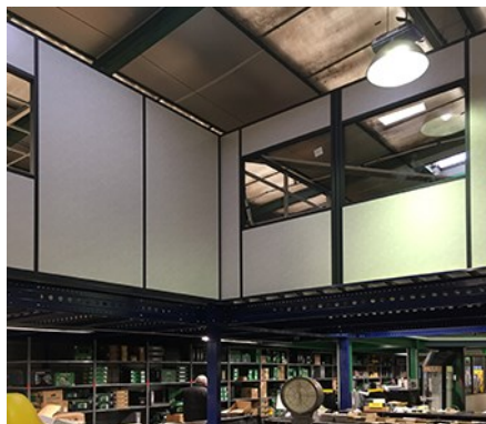
Aménagement de bureaux sur la mezzanine
