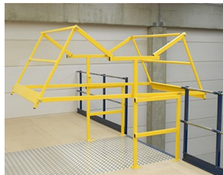
Position intermédiaire de la barrière écluse
