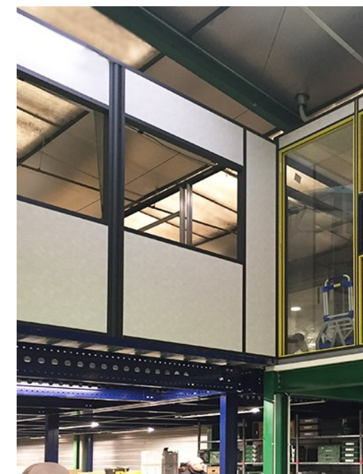
Extension des bureaux sur une nouvelle mezzanine
