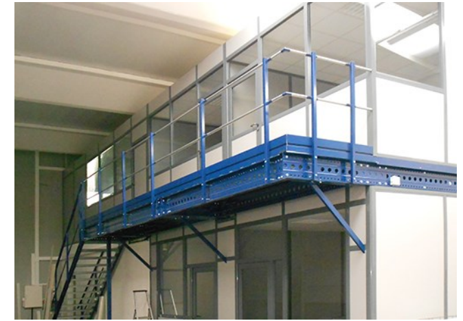
Mezzanine avec porte-à-faux
